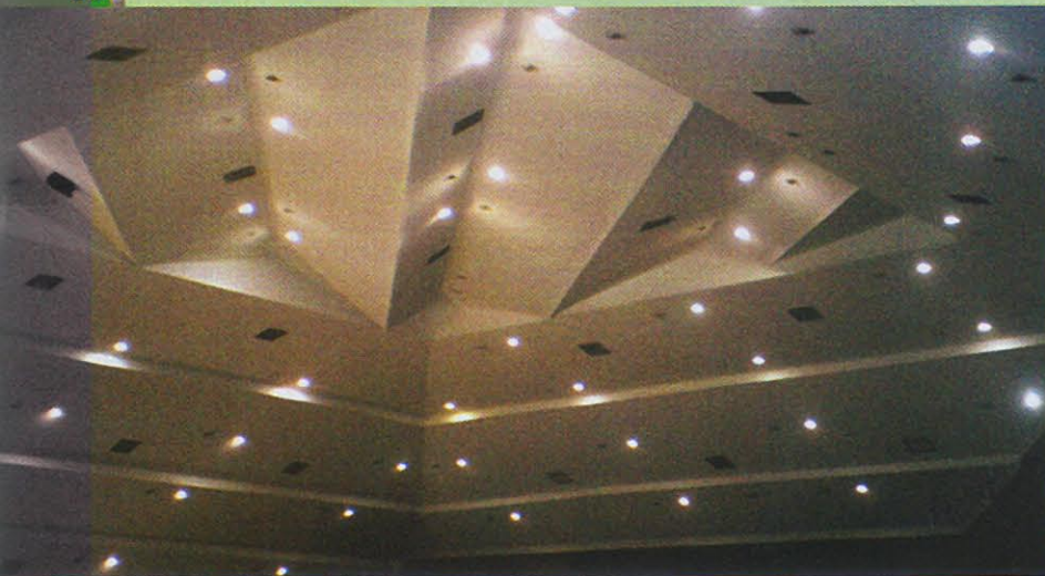
Rebaixamento de teto na Igreja do Nazareno de Campinas (SP): melhor qualidade de som
